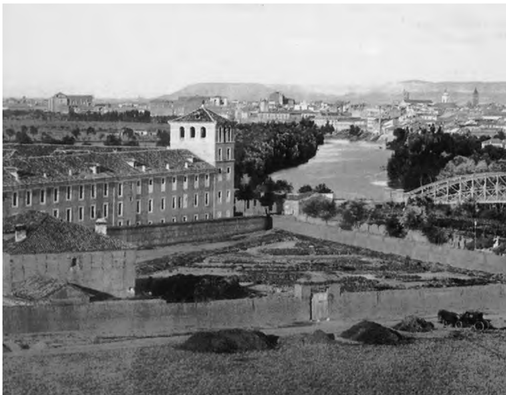
Vista aérea del Monasterio del Prado
